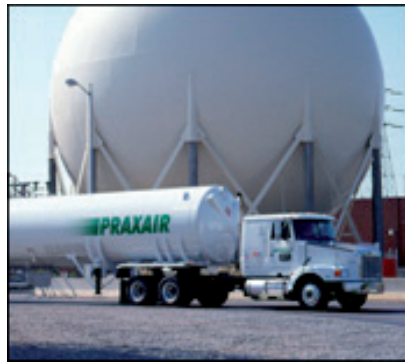
Hidrojenin gaz halinde veya sıvılaştırılmış şekilde çok yüksek basınca dayanıklı özel depolarda tutulabilmektedir.
